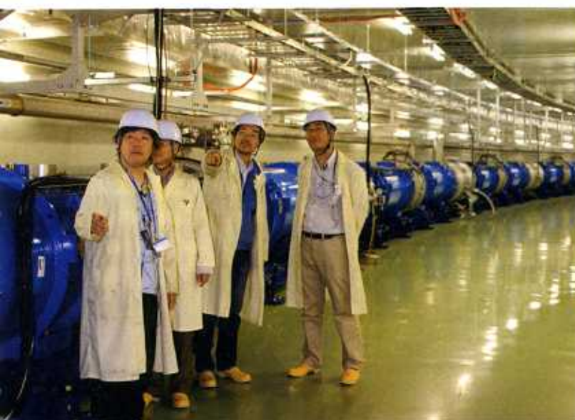
陽子を取り出す メインリングから陽子を取り出し、ターゲットへと導くビームライン。超電導磁石がずらりと並んでいる(78ページの写真の④)。
